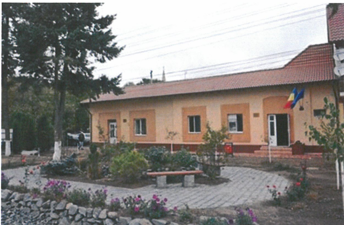
Foto: Clădire Primărie Moșnița Nouă
