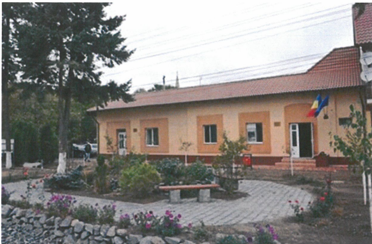
Foto: Clădire Primărie Moșnița Nouă
